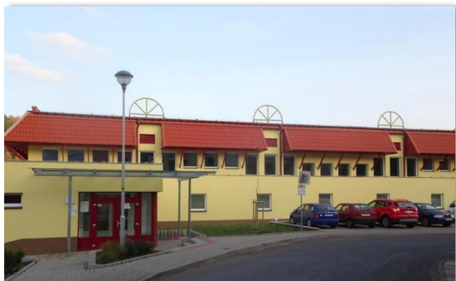
Opravená a zateplená tělocvična
